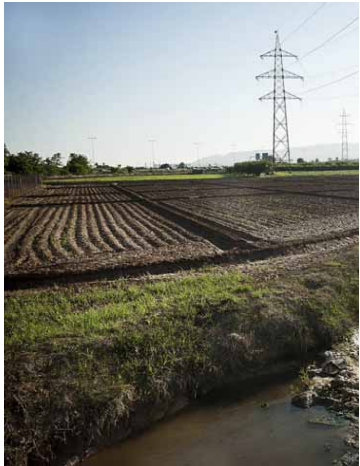
El Canal de la Dreta del Llobregat va arribar a
